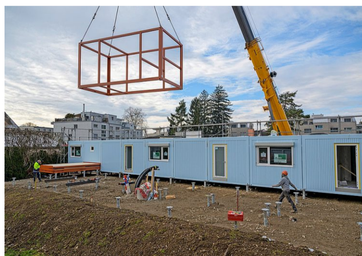
Auf das Erdgeschoss werden zwei weitere Etagen sowie Treppen und Balkone an der Aussenfassade folgen. Foto: Michael Trost
